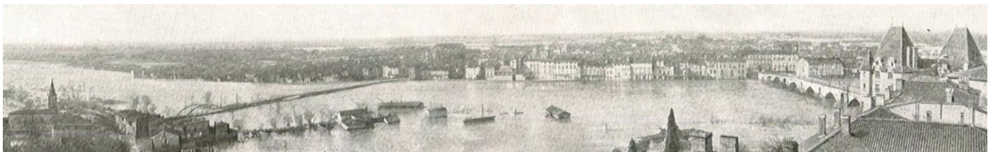
Crue de mars 1930 à Montauban
