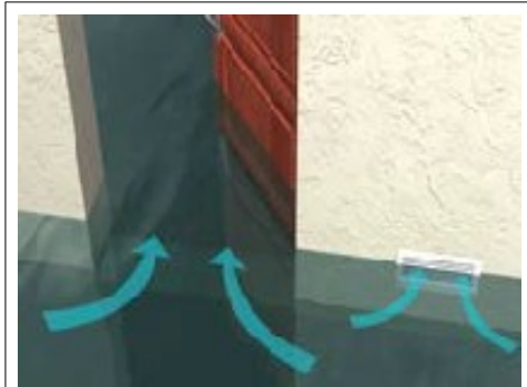
Situation initiale: l'eau pénètre par les portes et entrées d'air
